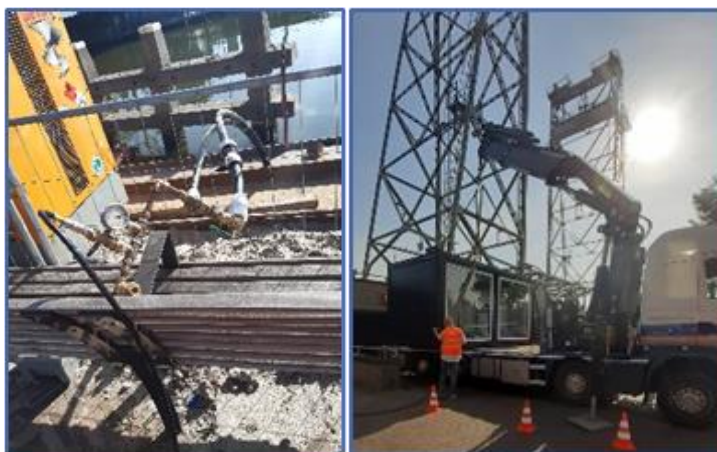
Figuur 2.4 druktest leidingwerk en transport testunit
