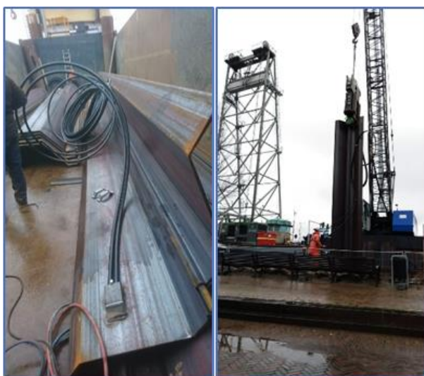
Figuur 2.3 Voorbereiden en plaatsen van de damwandplanken
